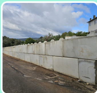
CONSTRUÇÃO DE MURO NO ESPINHO
