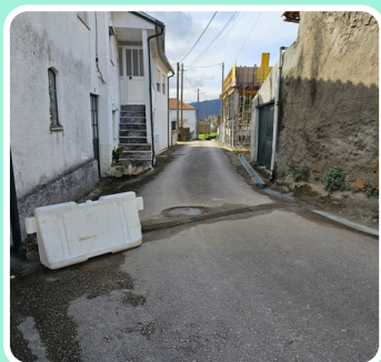
ALARGAMENTO DA RUA DO OLIVAL NO BUBAU
