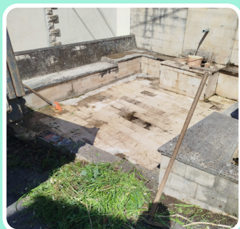
MANUTENÇÃO DE FONTANÁRIOS
