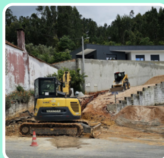
PAVIMENTAÇÃO E INFRAESTRUTURAS NOS MOINHOS
