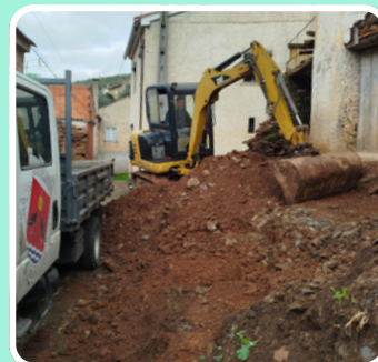
ALARGAMENTO DE RUA NO VALE DO AÇOR
